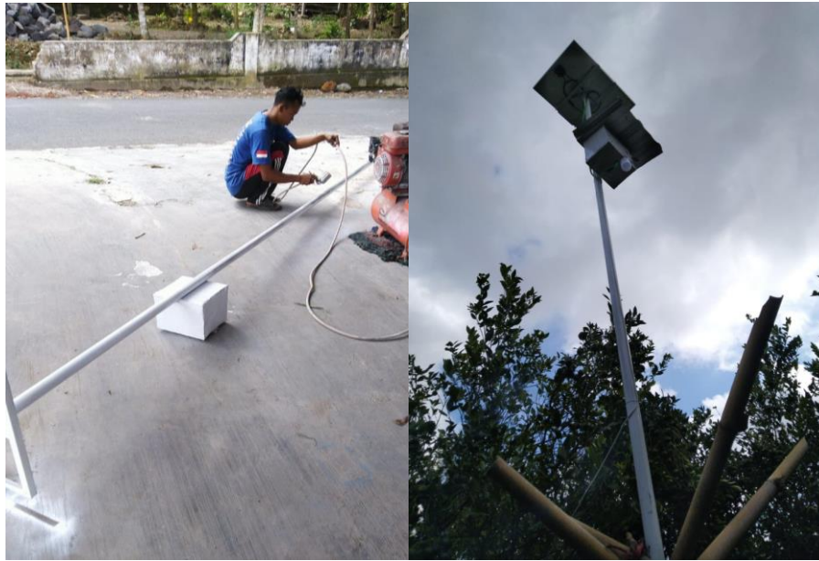
Gambar 5. Fabrikasi dan pemasangan perangkat hama berbasis tenaga surya
