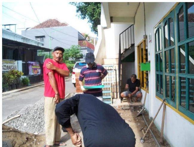
Gambar 3. Pekerjaan Galian Tanah
