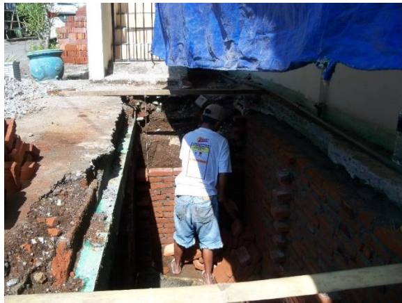
Gambar 4. Pekerjaan Pembuatan Septictank
