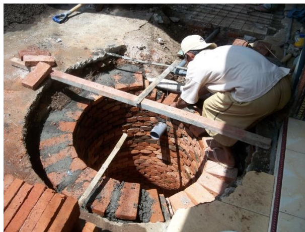
Gambar 5. Pekerjaan Pembuatan Sumur Resapan
