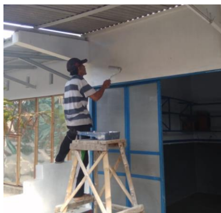
Gambar 1. Persiapan Melakukan Renovasi, pembenahan dan Pengecatan Calon tempat Rintisan Pendirian Bengkel Sepeda Motor
