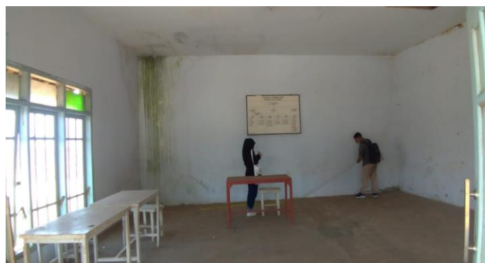
Gambar 3. Survey pengukuran ulang bangunan
