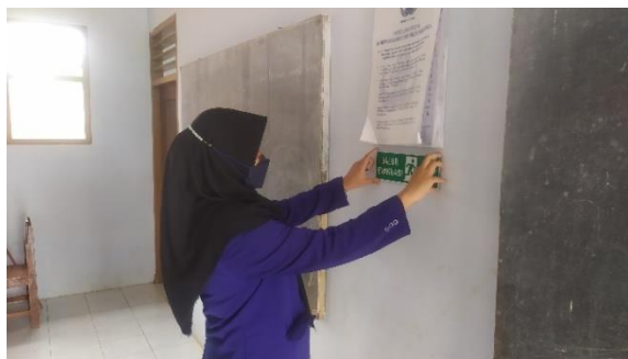
Gambar 4. Pemasangan Rambu Jalur Evakuasi di Ruang Kelas
