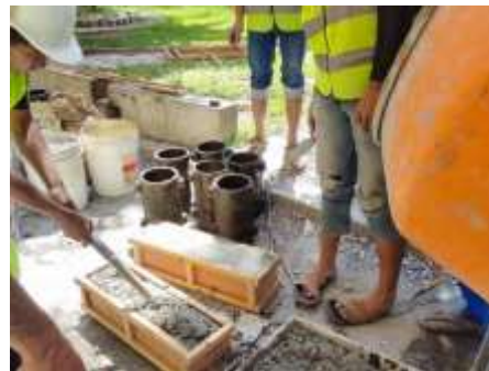
Gambar 9. menuang adonan beton ke dalam cetakan
