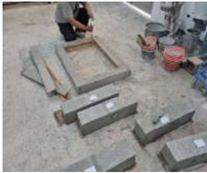
Gambar 10. pembongkaran bekisting
