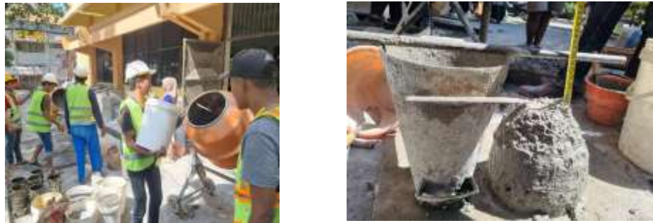
Gambar 8. mencampur material pengecoran (kiri), pengujian slump beton (kanan)
