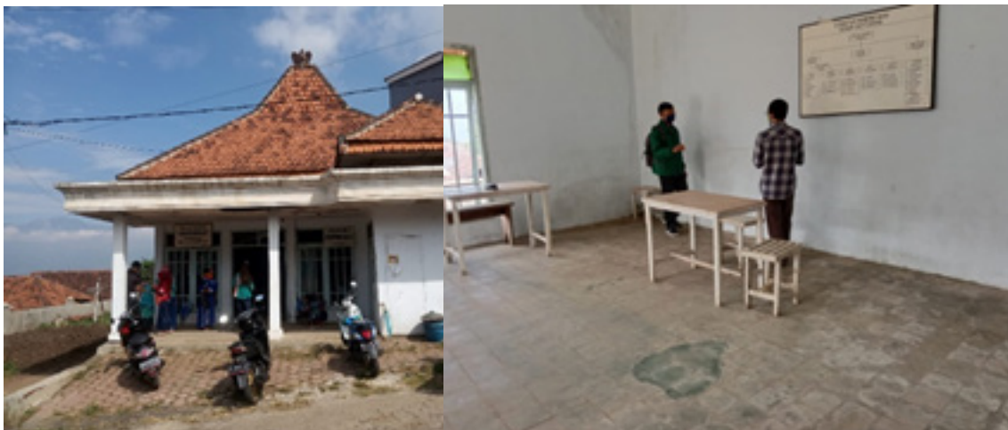
Gambar 1. Objek Studi Bangunan
