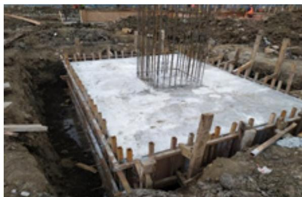
**Gambar 12.** Perawatan Beton
