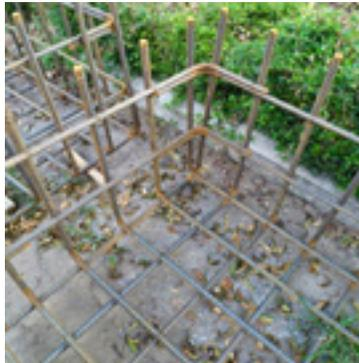
Gambar 6. Pekerjaan Pembesian Pile Cap
