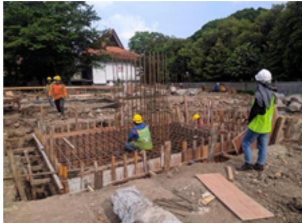
**Gambar 8.** Pekerjaan Bekisting
