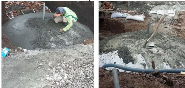
Gambar 5. Bagian Kubah Reaktor Biogas
