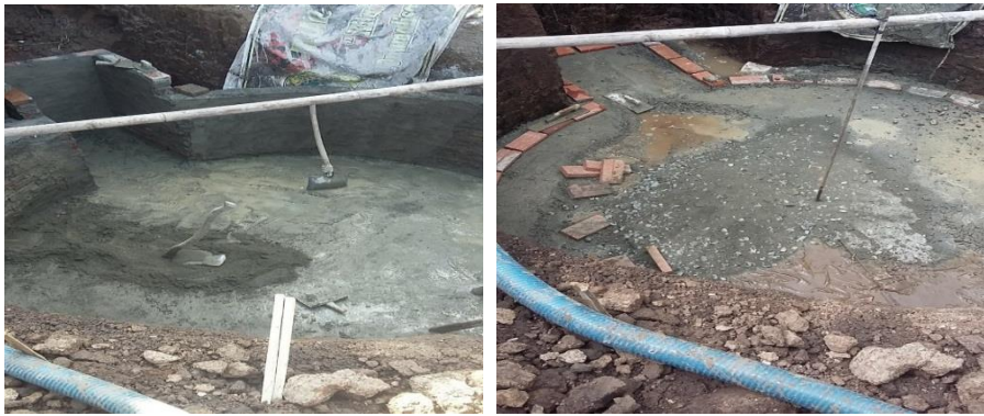
Gambar 4. Bagian Dasar Reaktor
