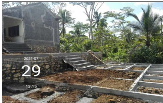
Gambar 9. Pekerjaan Pondasi Dapur dan KMWC
