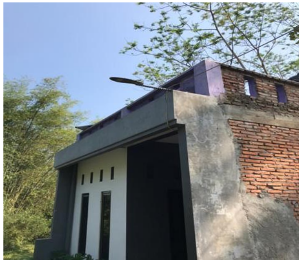
Gambar 5. Lampu penerangan LED DC dipasang di halaman Asrama panti asuhan Nurul Alim dengan daya listrik DC 25 Wat 12 Volt DC
