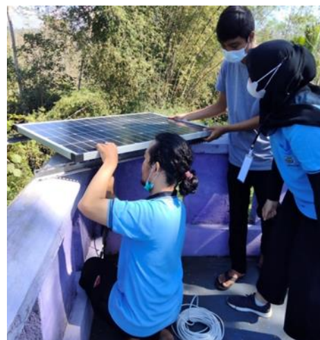
Gambar 3. Tim Pengabdian kepada masyarakat memasang panel surya untuk sumber daya listrik DC Sumber : Dokumen Pribadi
