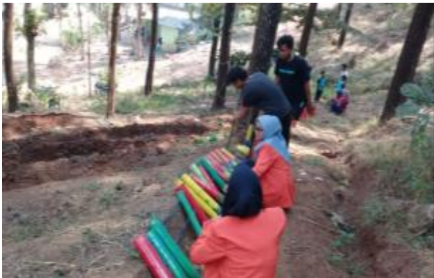
Gambar 6. Kegiatan Pemasangan Pagar untuk Taman (TOGA)
