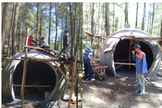
Gambar 3. Pembangunan Eco-Smart Mini Lab
