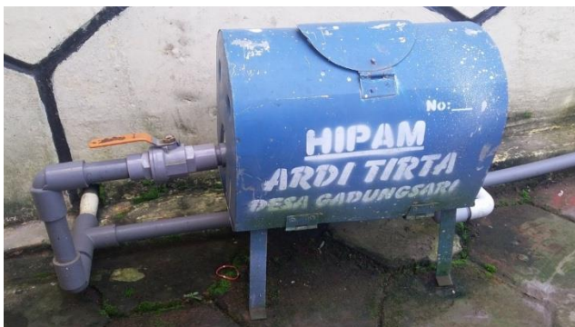
Gambar 2 Sistem meteran air yang dikelola oleh HIPAM Ardi Tirta Desa Gadungsari
