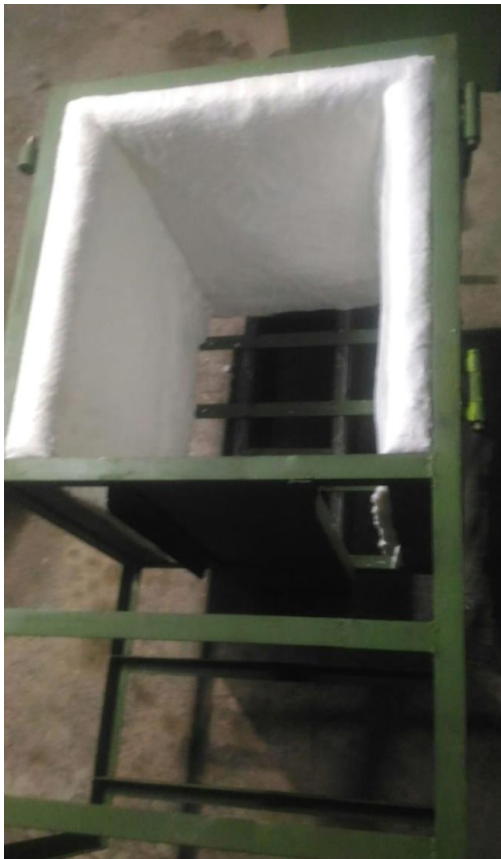
Gambar 2 Pemasangan ceramics fiber tahan api
