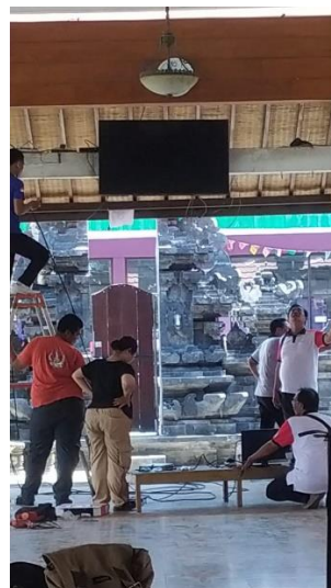
Gambar 4. Penyambungan Kabel CCTV ke Televisi di wantilan banjar Sampalan
