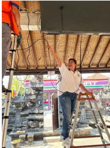
Gambar 3. Penarikan Kabel CCTV di dalam Wantilan Banjar Sampalan
