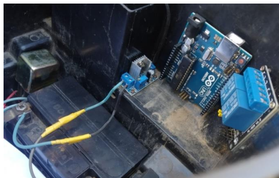
Gambar 11. Pemasangan board arduino uno dan modul relay
