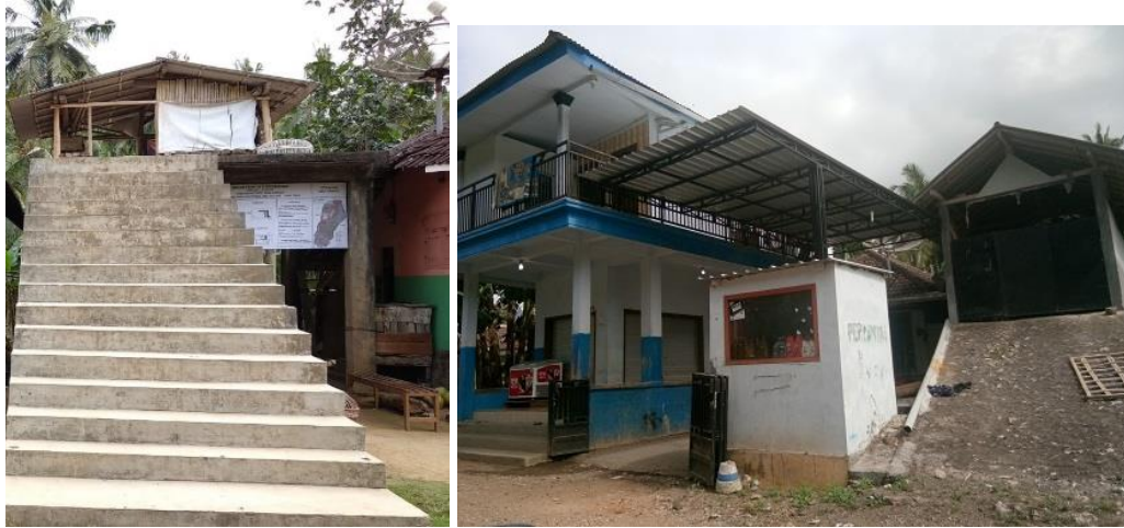
Gambar 4. Tempat evakuasi komunal (a) dan salah satu rumah warga yang didesain dua lantai, termasuk garasi rumah (b) (Dokumentasi peneliti, 2019)
