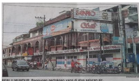
Gambar 1. Bangunan Pertokoan yang berdiri di atas saluran air (Drainase) di Kota Mojokerto (sumber: Radar Mojokerto, 2004d)
