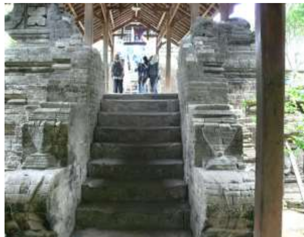
Gambar 7. Foto Tangga Menuju Cungkup Makam (Sumber: Dokumentasi Pribadi 2011)
