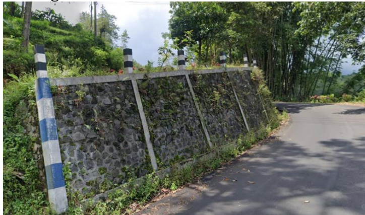
Gambar 1. Dinding Penahan Tanah di Desa Sukomulyo Sumber : Dokumen Pribadi
