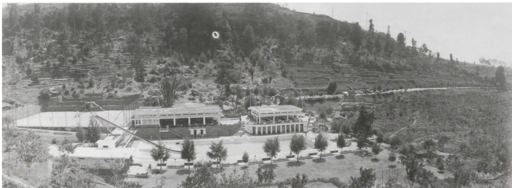
Gambar 5. Zwembad Selecta pada tahun 1940, lengkap dengan kolam renang, hotel, lapangan tennis, bungalow, dan taman. (sumber: Schaik, 1996)
