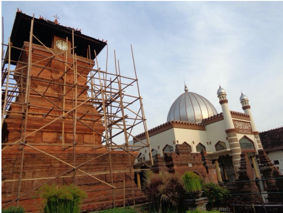
Gambar 1. Foto renovasi Menara Kudus, koleksi penulis tahun 2014.
