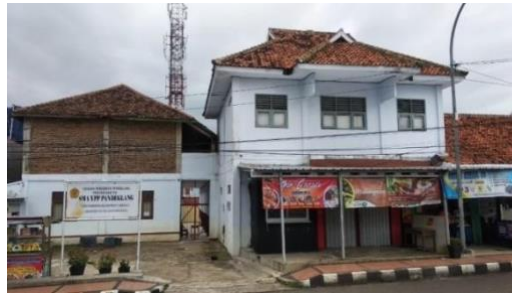
Gambar 12. Lahan depan SMA YPP Pandeglang tahun 2020 (Sumber: Dokumentasi Pribadi Peneliti, 30 November 2020)
