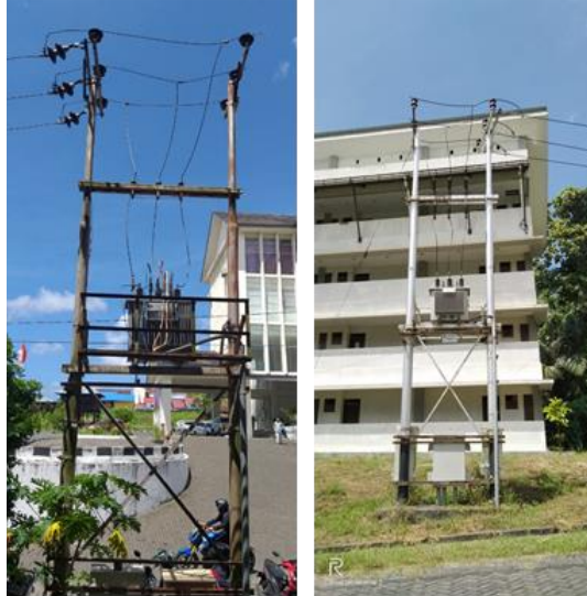
Gambar 2. Transformator dan Komponen Pendukung
